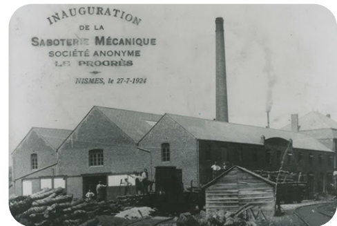
La Saboterie "Le Progrès" à Nismes. ©Collection - Ecomusée du Viroin
